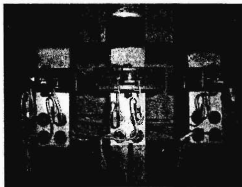
ნახ. 11.14. დენის ტრანსფორმატორების მონტაჟი სალტებზე
